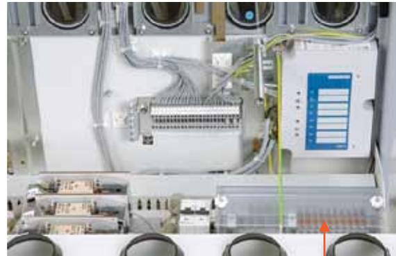
Клеммная колодка (пломбируемая) для подключения измерительного оборудования
