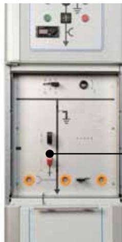
8. Рукоятка механического переключения автоматического выключателя в положении «отключено»
