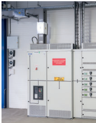
Распределительное устройство Eaton Capitore 20 для подачи питания в шинопроводы Power Xpert® XP и Power Xpert® MP
