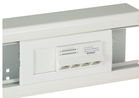
Abgeschlossene Montage im tehalit Kanal
